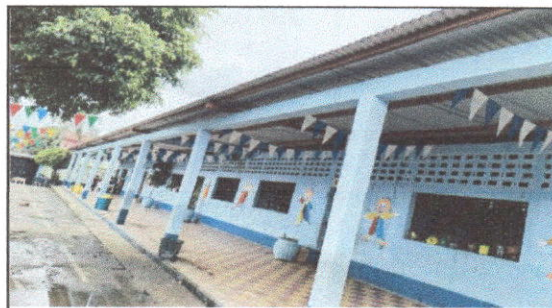
FOTO 8: Pintura en muros exteriores e interiores
