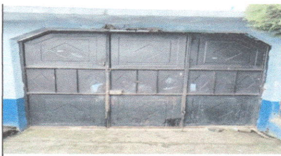
FOTO 9: Fabricación e instalacion de porton de metal de ingreso
