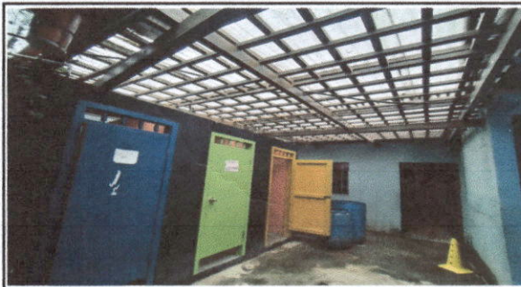
FOTO 3: Sustitución de lámina, por lámina troquelada aluzinc calibre 26 y sustitucion de estructura de madera por metal en modulo de baños
