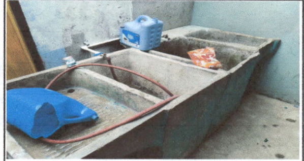
FOTO 2: Sustitución de pila de cemento de dos lavadero
